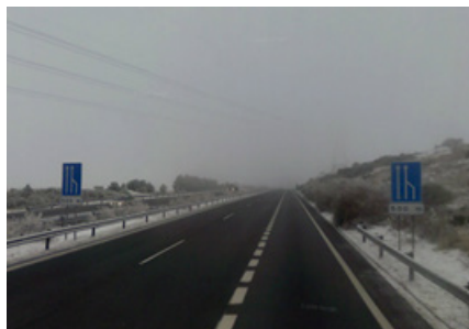
Ilustración 35 Autopista del Noroeste, Castilla y León. Fuente: Google Street View (2008))
