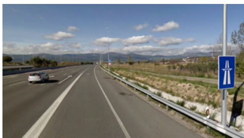
Ilustración 31 Autopista A6, Madrid. Fuente: Google Street View (2008))
