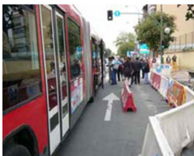
Ilustración 15 Balizamiento parada de autobús. Fuente: Manual de buenas prácticas preventivas en obras de infraestructuras urbanas del Ayuntamiento de Madrid
