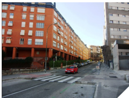
Ilustración 1 Sin semáforo, pintado y sin señalización vertical.
