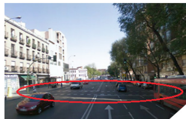
Ilustración 12 Con semáforo, sin pintar y con líneas discontinuas separadas de 3 a 5 m.
