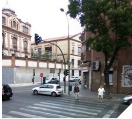
Ilustración 4 Con semáforo, pintado y sin refugio.
