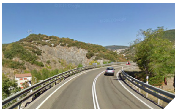
Ilustración 39 Margen peligroso con marcas viales, resaltos, hitos de arista, captafaros y/o barrera de seguridad.
