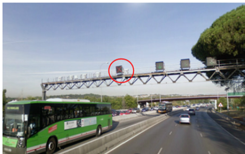
Ilustración 23 Carretera A6, Madrid. Fuente: Street View Google (2008).
