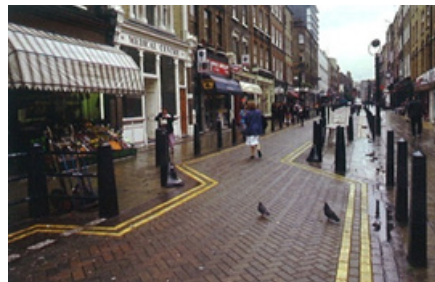
Ilustración 26 Tramo de calle en zigzag. Londres. Fuente: Calmado de Tráfico, Ministerio de Fomento
