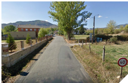
Ilustración 21 Sin dispositivos reductores de la velocidad ni canalización de tráfico peatonal.
