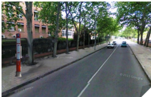
Ilustración 16 Con poste en tramo recto.
