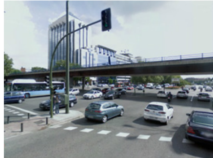
Ilustración 33 Madrid. Intersección de Paseo de la Castellana y calle de Raimundo Fernández Villaverde. Fuente: Google Street View
