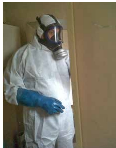
Figura 2. Verificación de la correcta colocación de los equipos de protección personal (EPI) antes del inicio de los trabajos
