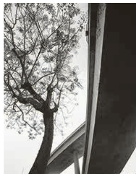
Paso bajo las autopistas interestatales 405 y 10, Los Ángeles, 2008-2013
